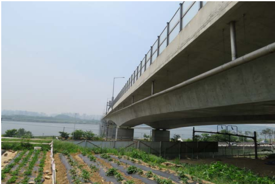
미사대교(양양) 측면 전경
