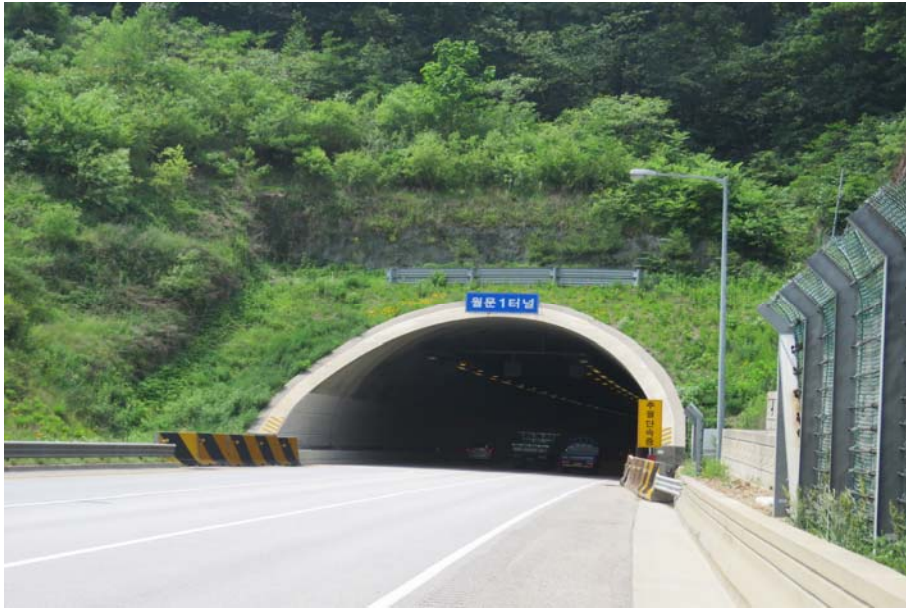
월문1터널(서울) 외부 전경
