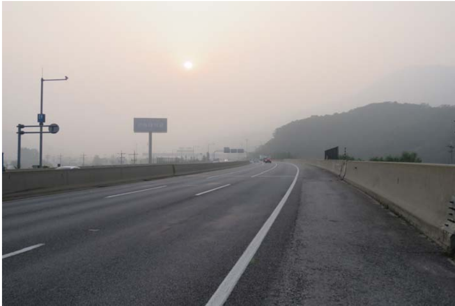
월문3교(양양) 상부 전경
