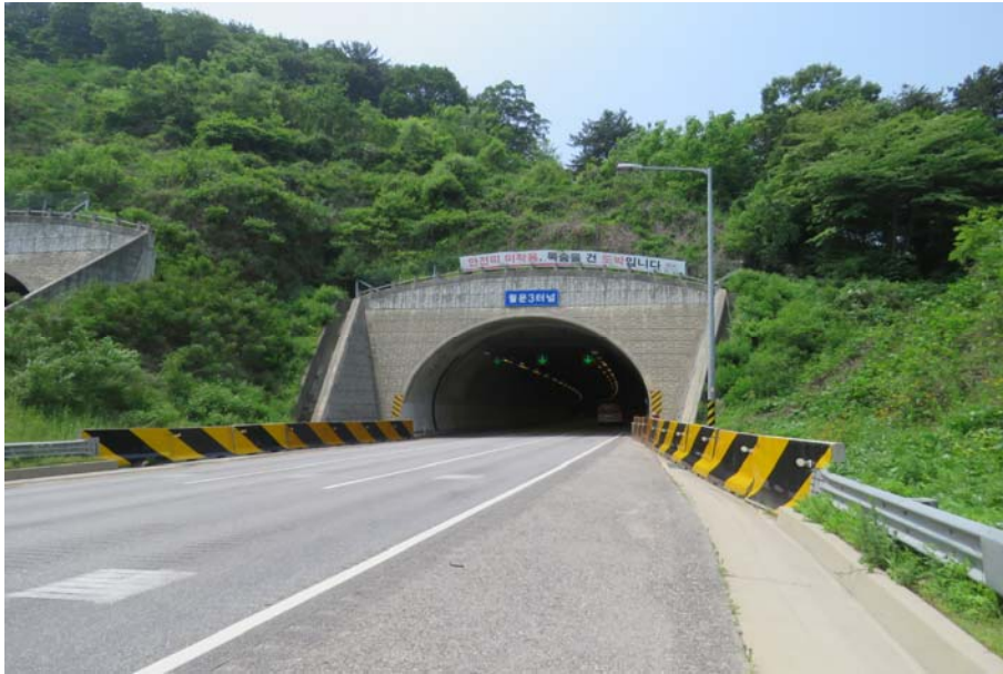
월문3터널(서울) 외부 전경
