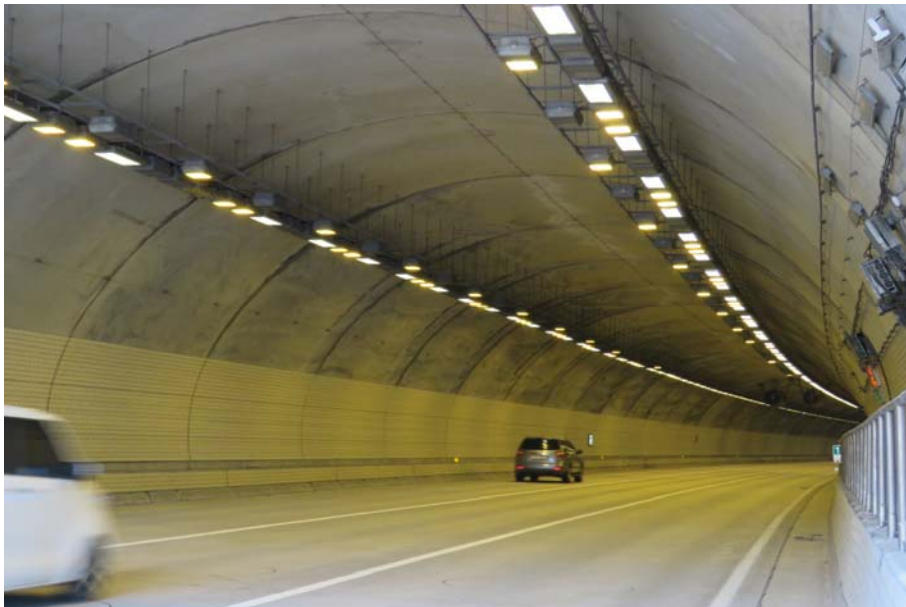
월문1터널(서울) 내부 전경
