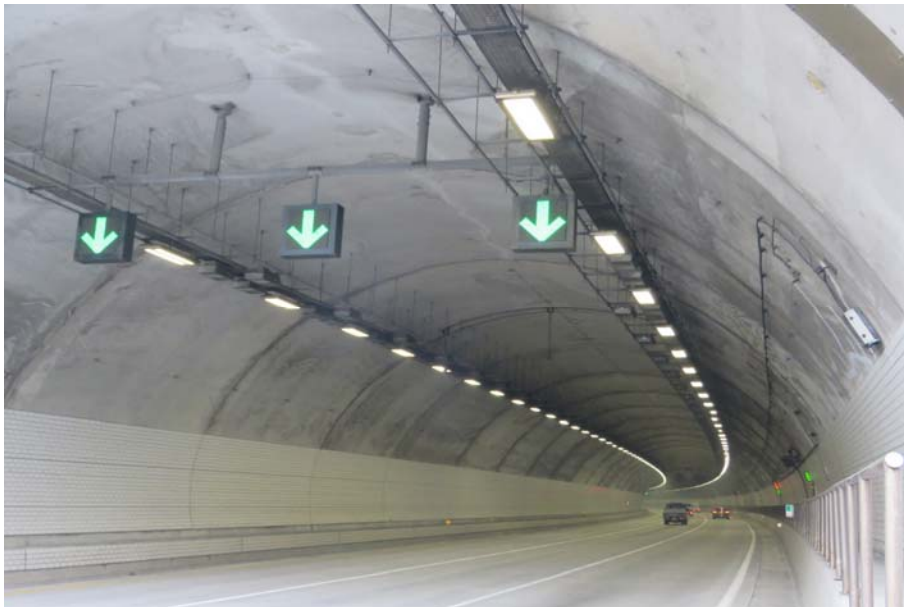
월문1터널(양양) 내부 전경
