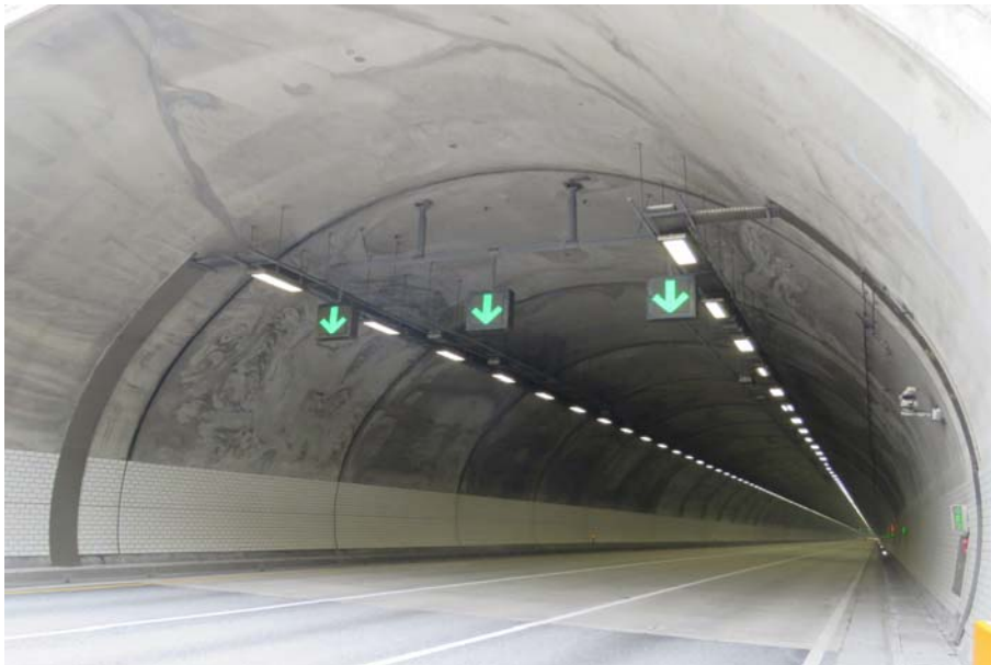
월문3터널(양양) 내부 전경
