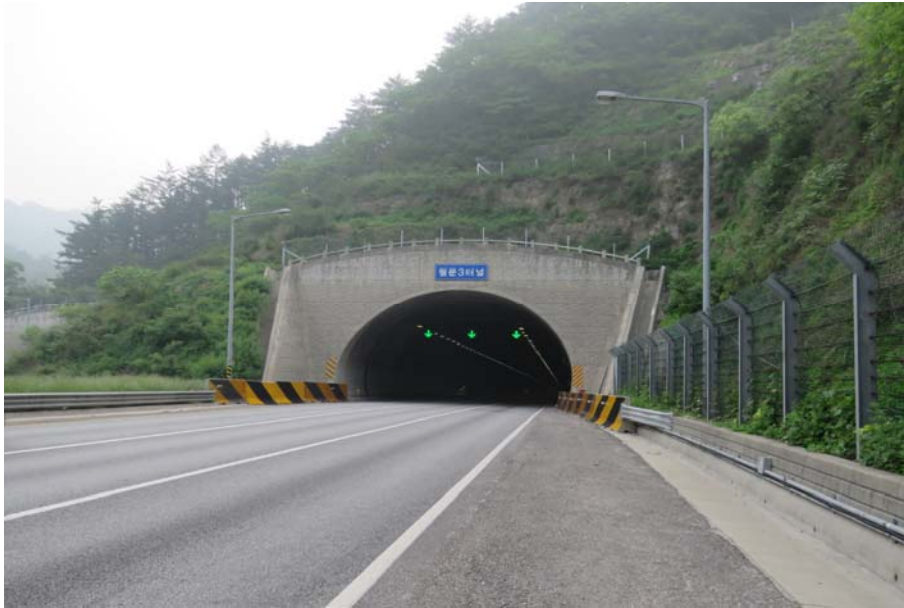
월문3터널(양양) 외부 전경
