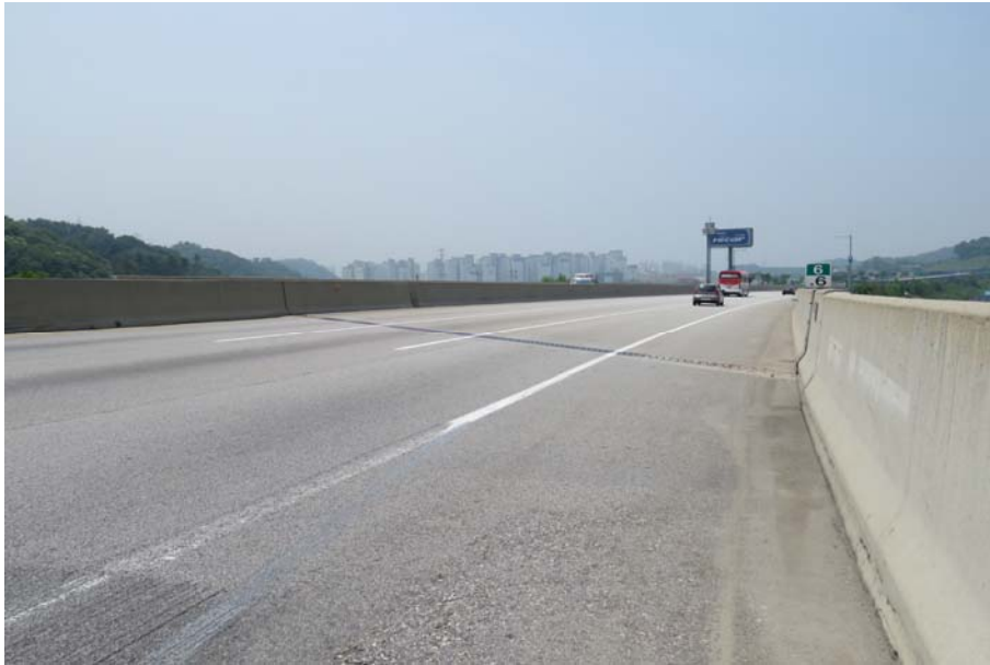
월문3교(서울) 상부 전경
