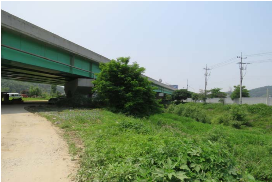
월문3교(서울) 측면 전경
