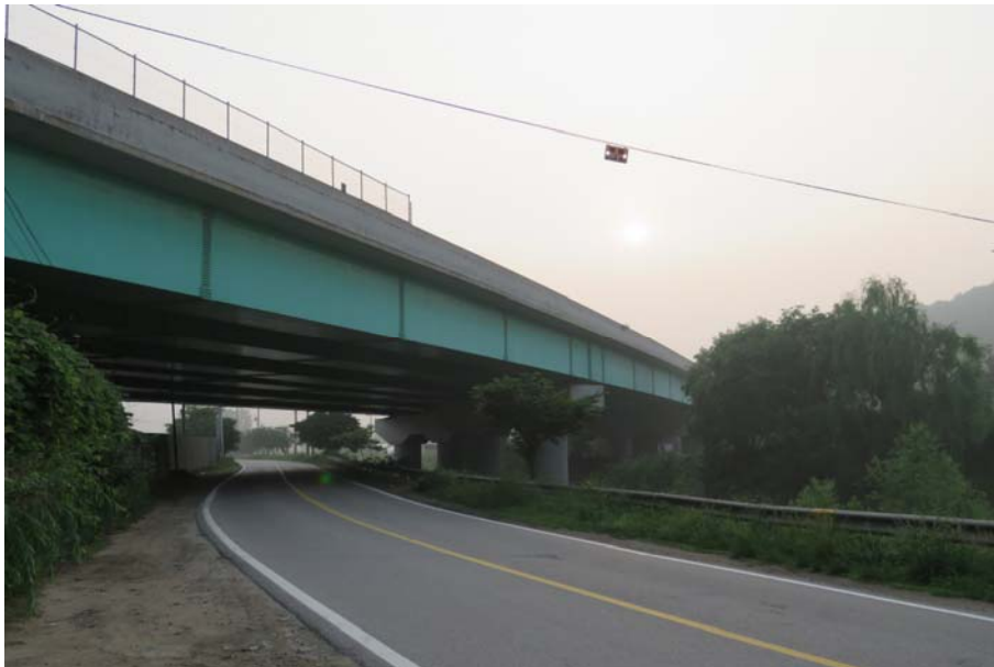
월문3교(양양) 측면 전경
